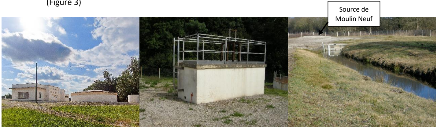
Figure 3 : Station d'eau potable de Saint-Fraigne, forage de Moulin Neuf, source de Moulin Neuf et déversoir de la source (Photographie SIAEP Nord-Ouest Charente)
