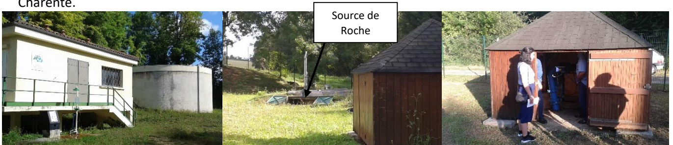
Figure 3 : Station d’eau potable de Roche, source de Roche et forage de Roche (Photographie SIAEP Nord-Ouest Charente)
