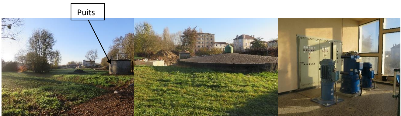
Figure 3 : Les Puits de Vars, bac de mélange et station des Puits de Vars (Photographie SIAEP Nord-Ouest Charente)
